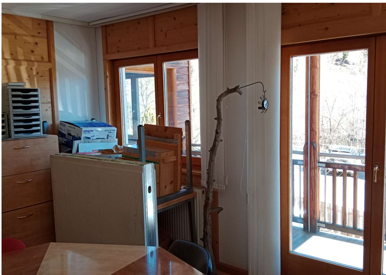
Uffici Piano Primo
